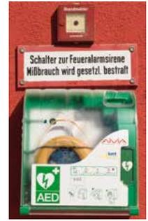
Das Gerät befindet sich in einem beheizbaren Gehäuse und ist somit auch in der kalten Jahreszeit einsatzbereit.
