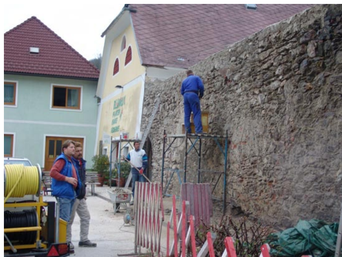
VbGm. Pirolt bei der Stadtmauersanierung
